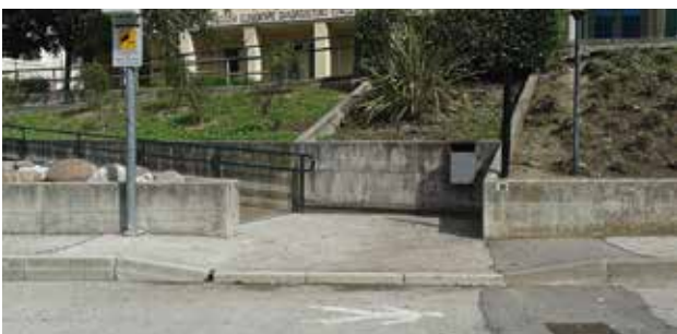
FOTO n. 8 - Via Stazione (entrata scuola elementare) Manca raccordo strada-marciapiede
