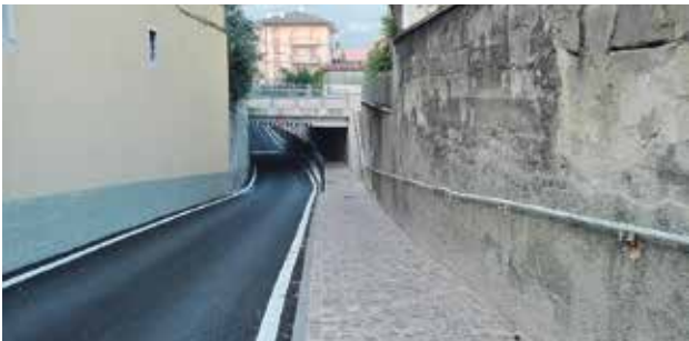
DOPO l'intervento - Nuovo marciapiede con larghezza adeguata
