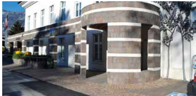
DOPO l'intervento - Adeguamento raccordo strada-marciapiede
