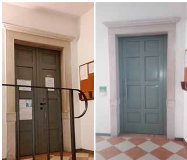
DOPO l'intervento - Porta ad anta unica con larghezza idonea
