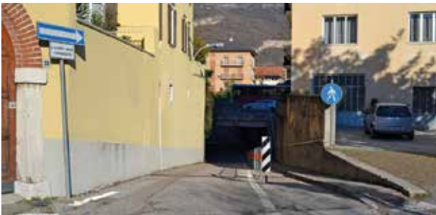
FOTO n. 7 - Via Stazione Larghezza marciapiede non a norma
