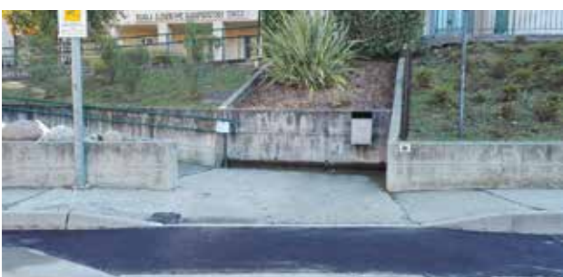
DOPO l'intervento - Adeguamento raccordo strada-marciapiede
