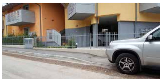
Tratto marciapiede esistente, raccordo accesso carraio realizzato con una cordonata inclinata.
