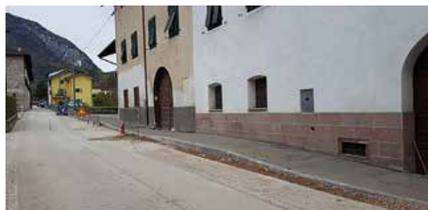
Completamento marciapiede, raccordo accessi carrai realizzati con due cordonate inclinate.
