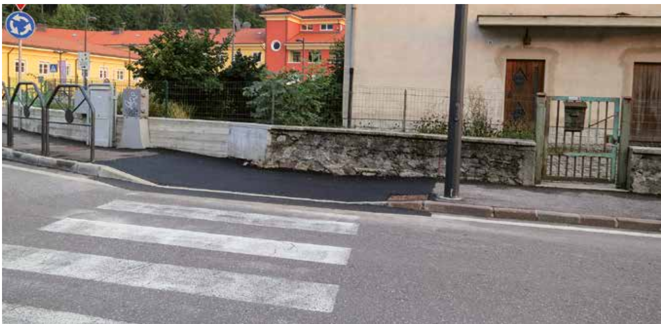
Attraversamento Via Spolverine dopo l'intervento
