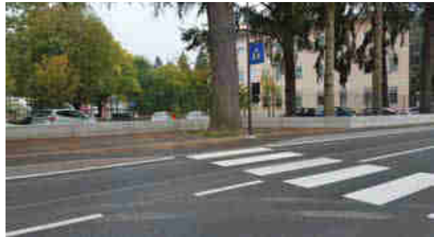
FOTO n. 10 - Vista la ridotta larghezza del marciapiede in curva, si è optato ad una soluzione a raso posando dei manufatti in metallo para-persone al fine di mettere il passaggio in sicurezza per le persone che vi transitano
