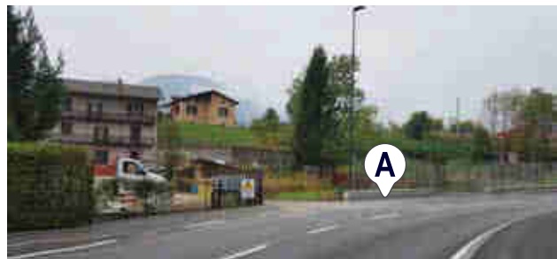
FOTO n. 8 - Raccordi con gli accessi carrai Sono stati realizzati posando due cordonate inclinate. Vista la presenza di tre accessi carrai consecutivi in prossimità del punto "A" il marciapiede non è stato rialzato ma mantenuto a livello strada posando solamente le cordonate in porfido per delimitare il marciapiede
