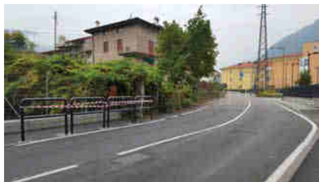
FOTO n. 10 - Vista la ridotta larghezza del marciapiede in curva, si è optato ad una soluzione a raso posando dei manufatti in metallo para-persone al fine di mettere il passaggio in sicurezza per le persone che vi transitano
