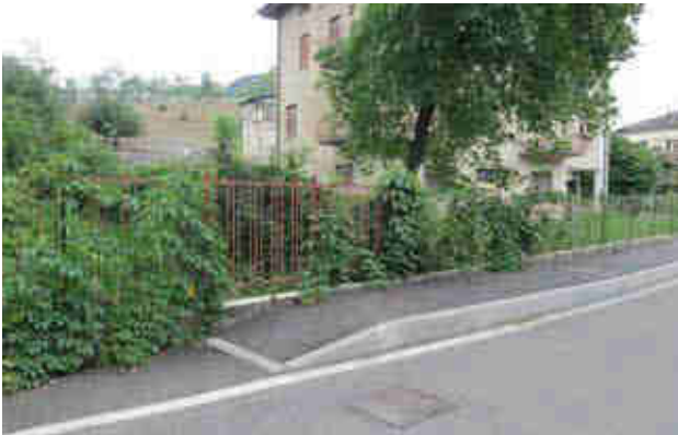
FOTO n. 6 - Marciapiede dopo dell'intervento Adeguatezza pendenza longitudinale raccordo. Sono state posate due cordonate inclinate in cls diminuendo notevolmente la pendenza longitudinale
