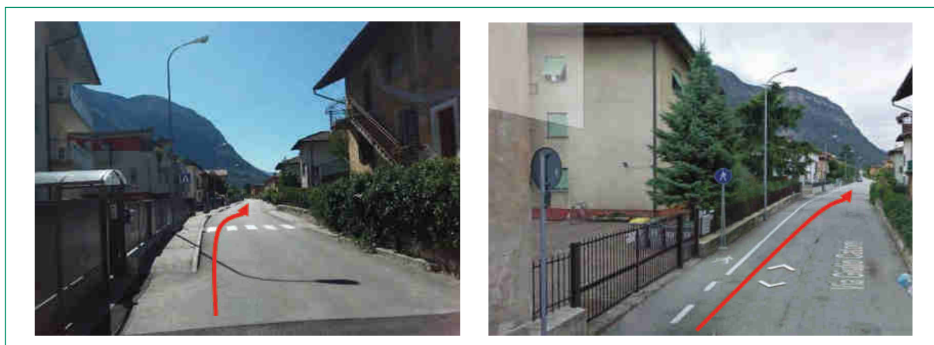
foto 05: Via Giulio Catoni, a sinistra com'è adesso, a destra com'era prima dei lavori; per evitare il susseguirsi di dossi scomodi e pericolosi nei periodi invernali in presenza di ghiaccio o neve, sarebbe stato sufficiente installare a tratti delle barriere in metallo parapersona lasciando così il percorso riservato ai pedoni continuo e usufruibile da tutti
