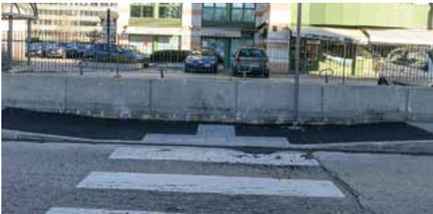
Risultato DOPO l'intervento
