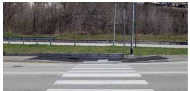
Risultato DOPO l'intervento
