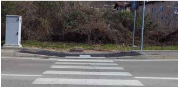
Risultato DOPO l'intervento
