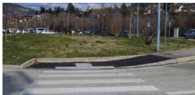
Risultato DOPO l'intervento
