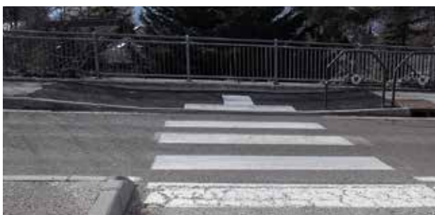
Risultato DOPO l'intervento
