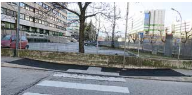
Risultato DOPO l'intervento
