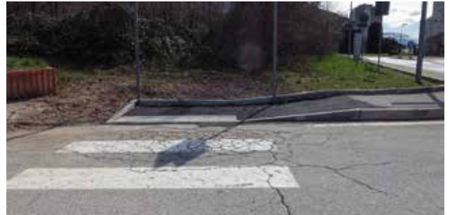
Risultato DOPO l'intervento
