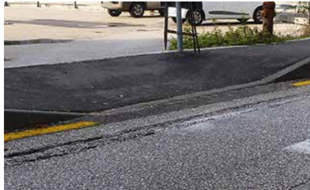
Errato raccordo strada-marciapiede pendenza trasversale 17%
